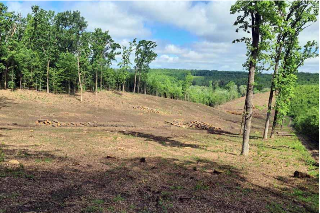
Рис. 3. 3. Загальний вигляд ділянки № 2.
